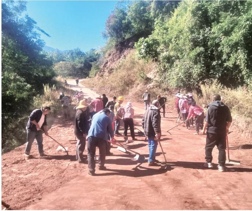
漾濞县瓦厂乡黑马村村组干部带领党员、群众在修复进组道路。(摄于12月1日) 为改善村民出行条件,黑马村坚持干部带头、党员示范,积极发动党员、村民代表、志愿者修复六组、七组进组道路,守护群众出行安全。
