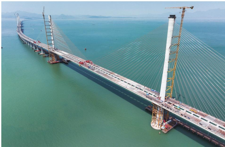
2024年3月20日,随着高栏港大桥主跨合龙梁段的最后一块焊缝精准焊接,黄茅海跨海通道高栏港大桥合龙(无人机照片)。
