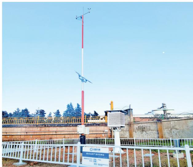
12月16日,大理州首个油库自动气象站在振戎油库生产区建成,并验收投入使用。该气象站由大理石油分公司投资,大理州气象局负责建设和运维,主要用于实时监测油库生产区的气温、降水、风向、风速、湿度、气压等气象要素,实现气象数据监测与传输同步进行。
