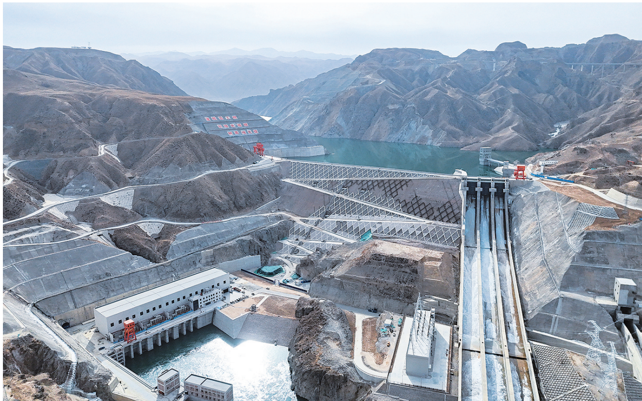
这是12月24日拍摄的羊曲水电站(无人机照片)。当日,位于青海省黄河上游的羊曲水电站最后一台(3号)机组通过72小时试运行正式并网发电,标志着羊曲水电站按期实现全容量投产发电目标。 羊曲水电站位于青海省海南藏族自治州兴海县与贵南县交界处的黄河干流河段,是国家规划建设重点水电工程,电站主要设备国产化率达到90%以上,在国内首创采用镶嵌混凝土面板堆石坝新坝型,达到行业领先水平,为我国300米级高面板堆石坝建设提供了实践经验。 [新华社记者 张龙 摄]
