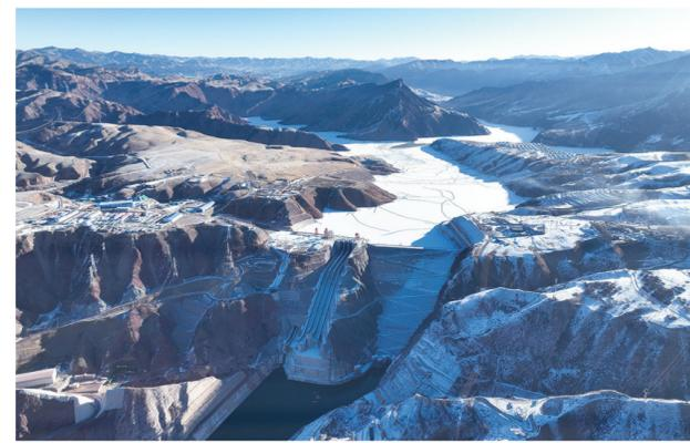
这是2024年12月31日拍摄的玛尔挡水电站（无人机照片）。2024年12月31日，国家能源集团宣布，公司旗下青海玛尔挡水电站全部机组当日并网发电。这是黄河流域海拔最高的水电站，也是黄河上游青海段首个千万千瓦级“水风光蓄”全清洁能源一体化基地的核心工程。玛尔挡水电站位于青海省海南藏族自治州同德县与果洛州玛沁县交界处的黄河干流上，所处地区平均海拔3300米，安装四台单机容量为55万千瓦和一台单机容量为12万千瓦的水轮发电机组，总装机容量232万千瓦，是黄河流域海拔最高的水电站，也是国家“西电东送”和“青电入豫”的骨干电源点。
