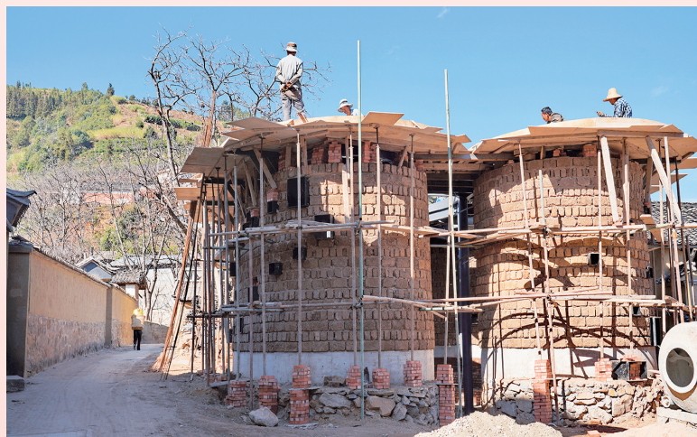
花桥村正在修建的艺术中心。将来,花桥村将以文化艺术为引,结合茶马古道文化底蕴,打造文旅新热地。
