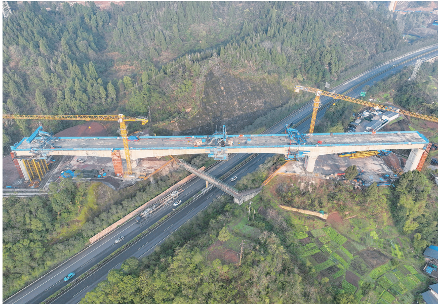
这是1月5日在四川省达州市境内拍摄的西渝高铁槟榔特大桥连续梁合龙施工现场（无人机照片）。当日，由中铁四局承建的西渝高铁成渝段槟榔特大桥跨包茂高速连续梁顺利合龙，为全线如期建成通车奠定基础。西渝高铁是全国“八纵八横”高速铁路通道之包（银）海、京昆通道重要组成部分，全长739公里，设计时速350公里。【新华社发 王曦 摄】
