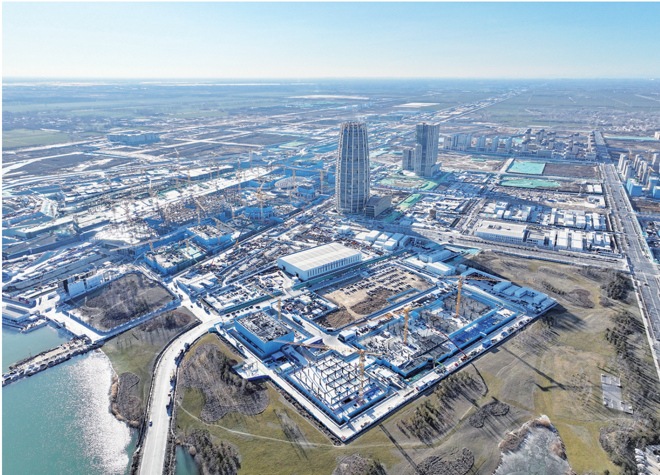
1月9日拍摄的中国矿产资源集团有限公司雄安总部项目建设现场（无人机照片）。
