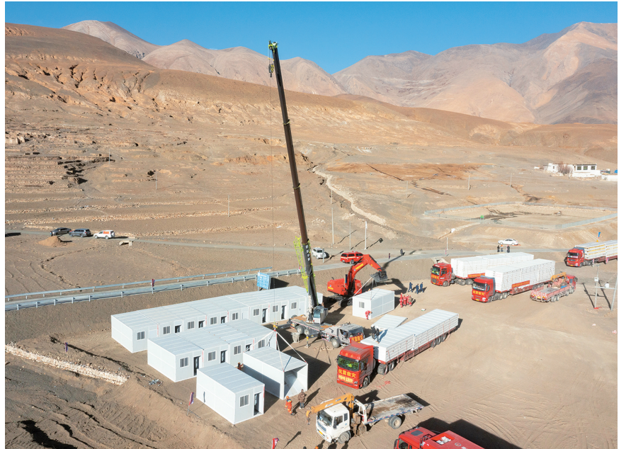
1月9日，工作人员在定日县长所乡嘎旦村搭建板房（无人机照片）。1月9日，在定日地震受灾严重的长所乡等地，各方救援建设者为让受灾群众尽早入住更为舒适的板房，更好地度过冬季，坚持在风沙中施工，抢抓建设进度。
