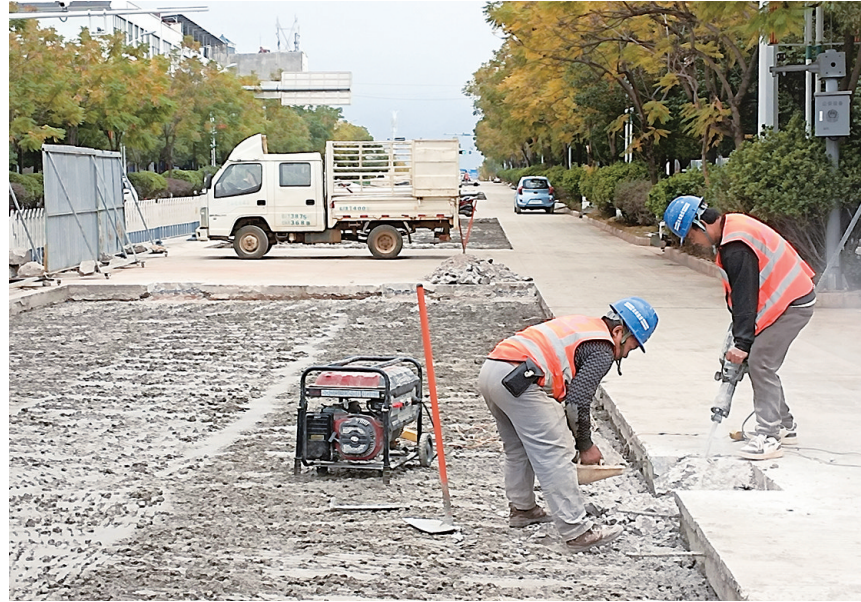
建设中的弥渡县城建北片区道路提升改造工程。(摄于1月12日) 弥渡县城建北片区道路提升改造工程投资1268万元,工程完工后,将有效改善道路的排水状况,提升城市防洪排涝能力,保护周边水环境,为居民提供更加舒适、便捷的出行环境。
