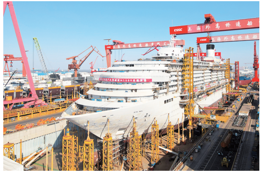
这是1月15日在上海外高桥造船有限公司2号船坞拍摄的国产大型邮轮“爱达·花城号”(无人机照片)。 当日,第二艘国产大型邮轮H1509船(“爱达·花城号”)在中国船舶集团有限公司旗下上海外高桥造船有限公司2号船坞内实现全船贯通,全面转入全船内装工程、设备、系统调试“下半场”。相比于首艘国产大型邮轮“爱达·魔都号”,“爱达·花城号”总吨位增加了0.64万吨达14.19万吨,总长增加17.4米达341米,客房数量增加19间达2144间,满载游客量5232人,配置高达16层的庞大上层建筑,增加更具体验感和娱乐化的相关设施。 【新华社记者 方喆 摄】
