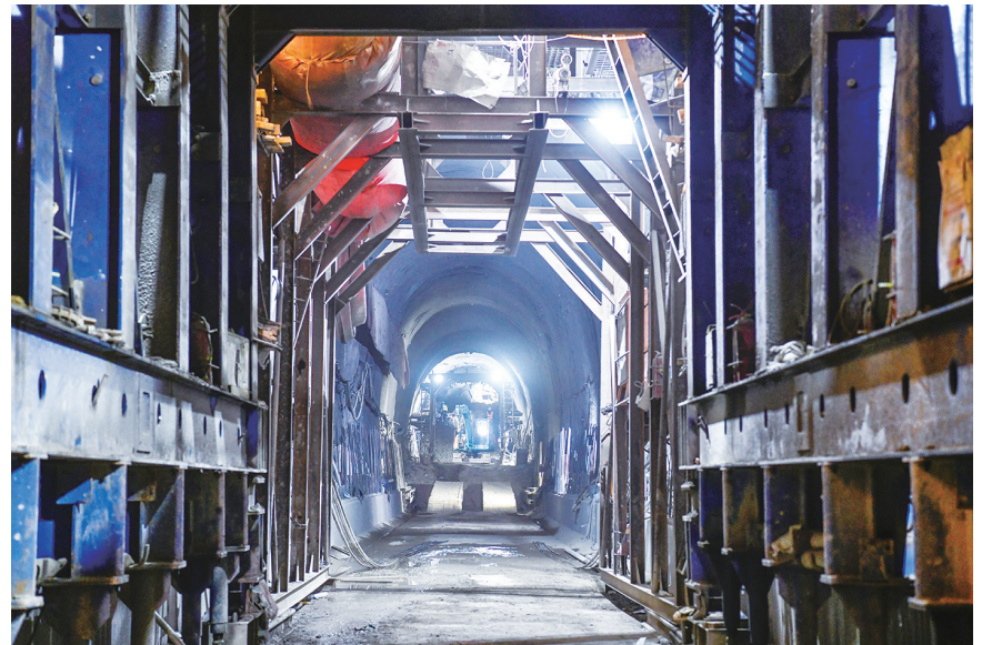
1月16日,工人驾驶挖掘机在贵州瓮马铁路南延线五七连隧道里施工。当日,由中铁二十局承建的五七连隧道顺利贯通,标志着贵州瓮马铁路南延线隧道全部贯通,为后续铺轨架梁工作奠定基础。 瓮马铁路南北延伸线北起瓮安延伸至遵义,南起马场坪延伸至都匀,全长148公里。 【新华社记者 杨文斌 摄】
