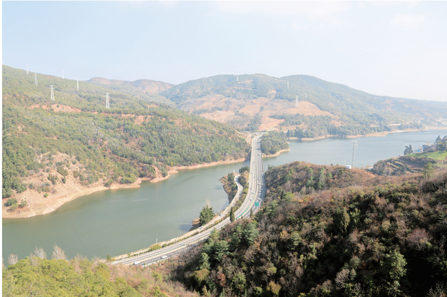
实现自动化、信息化管理的祥云县小官村水库。(摄于2月2日) 日前,投资1400万元的祥云县小官村、浑水海、青海湖、普溯、邵家、新兴苴及清水河7件中型水库自动化、标准化建设项目完工。水库自动化、信息化管理可实现水库水位、雨量、视频图像、渗压、渗流量、大坝变形等在线巡视监管,自动采集、存储、分析、上报数据,保障水库安全运行。
