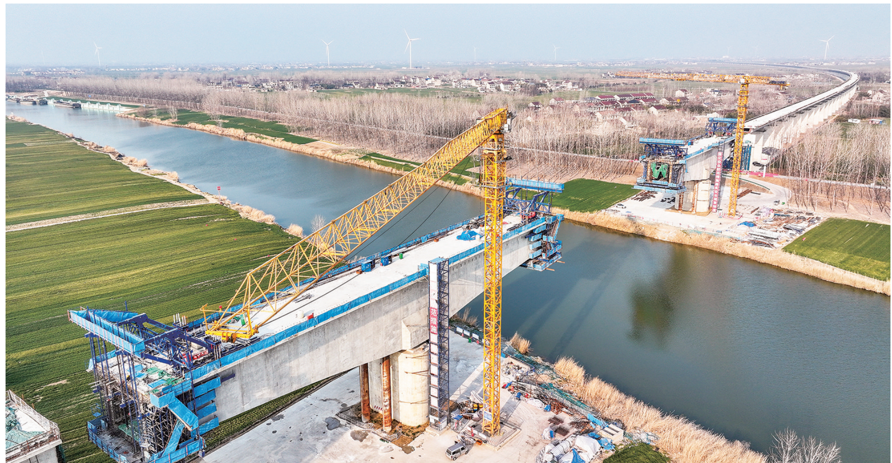
2月25日拍摄的中铁四局阜淮铁路跨湾河特大桥连续梁施工现场(无人机照片)。 开春以来,位于安徽省亳州市的中铁四局阜淮铁路建设现场一派繁忙景象,施工人员在抢抓春季有利天气,加紧施工,确保重点工程建设进度。阜淮铁路位于安徽省北部,途经阜阳、亳州、宿州、淮北,正线全长约142.5公里,设计时速350公里。【新华社发(刘玉才 摄)】
