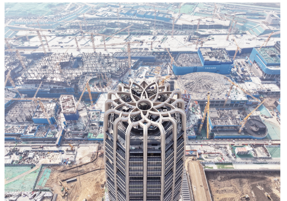
这是位于雄安新区启动区的中国中化大厦及国贸片区建设现场(2月27日摄,无人机照片)。早春时节,河北雄安新区多处建筑工地塔吊林立、机器轰鸣、车辆穿梭,数以万计的建设者以高标准高质量推进项目建设,呈现出一派热火朝天的繁忙景象。近年来,雄安新区加快集聚项目要素,开发建设保持强劲态势,大规模建设与承接北京非首都功能疏解取得明显成效。截至2024年底,雄安新区累计完成投资8354亿元,预计今年将完成投资2000多亿元。【新华社记者 牟宇 摄】
