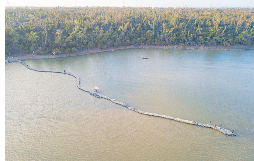
3月1日在海口市琼山区龙塘镇拍摄的“蛇桥”（无人机照片）。国仓村石桥位于海口市琼山区龙塘镇美味河畔，是明代名臣丘濬带领当地乡绅民众修建的系列水利工程中的一部分，距今已有500余年历史。其因形似长蛇伏卧河面，又被称为“蛇桥”。石桥由火山石修建，水涨则没，水退则显，一年只在初春至初夏时节浮出水面。近期，石桥再次显现，吸引了不少游客前来踏青观景，感受当地人文历史。【新华社记者 蒲晓旭 摄】
