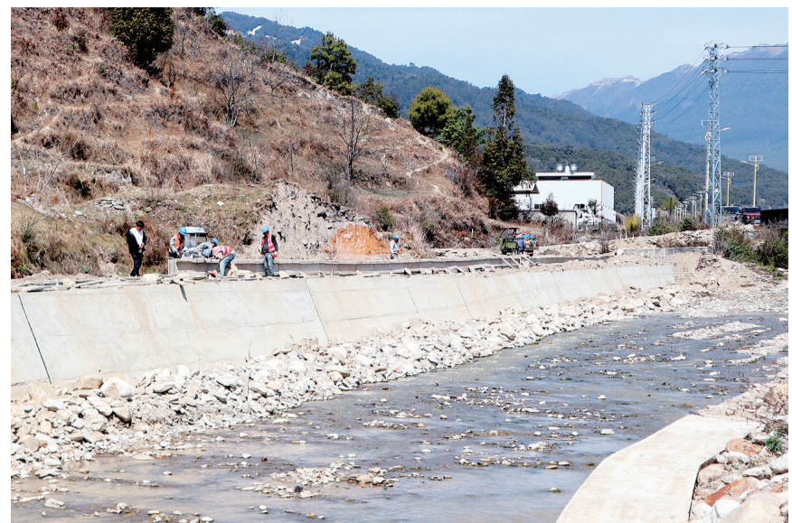
云龙县滑洞河治理工程施工现场。(摄于2月27日)
