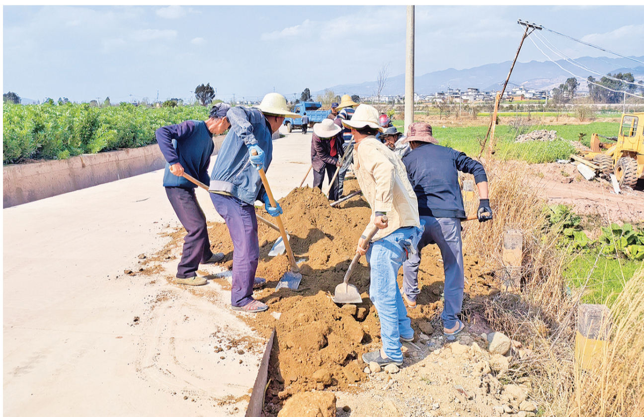
巍山县小川村群众投工投劳修建进村道路。(摄于3月4日)
