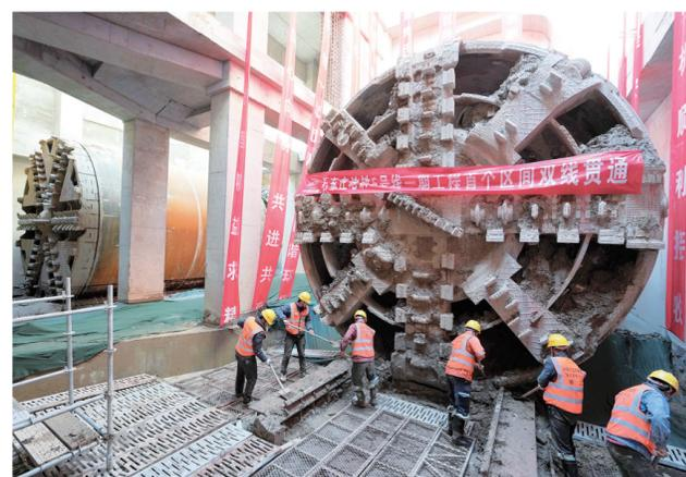
3月17日,中铁十四局集团的工人在石家庄地铁5号线体育北大街站建设工地清理盾构机上的泥土。
