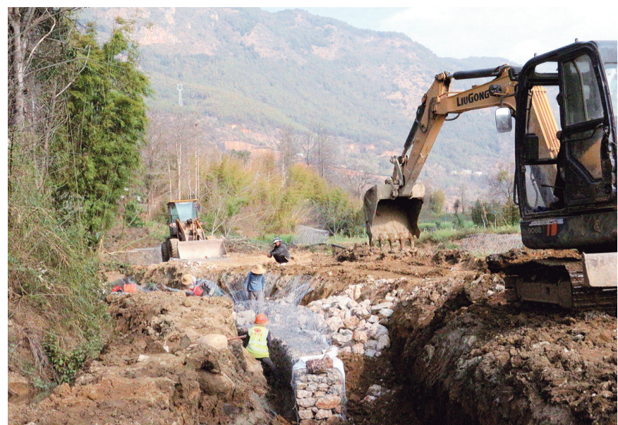
在弥渡县横沟河治理工程红岩段施工现场,挖掘机在进行堤防基础开挖作业,工人们紧张有序地推进施工进度。(摄于3月6日)
