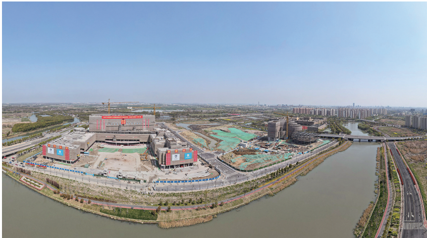
空中俯瞰复旦大学附属中山医院青浦新城院区一期工程建设项目施工现场(4月1日报,无人机全景照片)。
