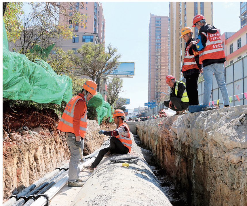
施工人员在祥云县城主城区安装地下管网。(摄于4月8日)
