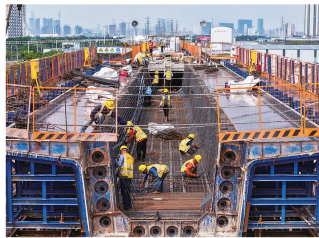
4月28日，施工人员在广南联络线跨路跨线特大桥桥址浇筑梁钢筋。当日，由中铁十一局承建的广（广州站）南（广州南站）联络线建设开启加速度，“永庆号”大直径盾构机始发，跨路跨线特大桥开始浇筑梁施工。广南联络线建成后，京广高铁、广深港高铁、贵广高铁、南广高铁等铁路线可直达位于中心城区的广州火车站，广州大都会交通枢纽功能将进一步增强。
