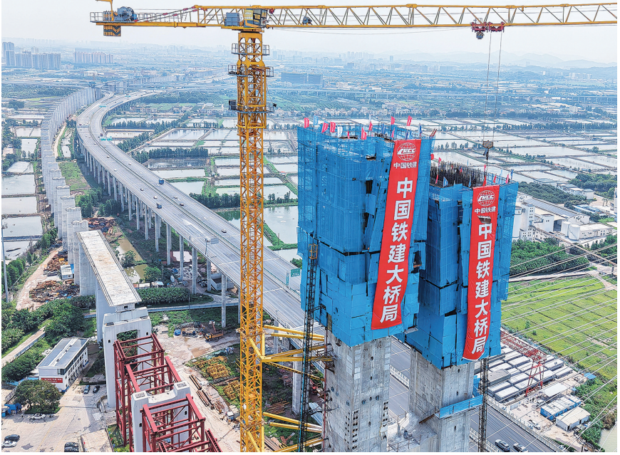
5月11日，深江铁路跨磨刀门水道主桥东主塔封顶（无人机照片）。当日，中铁建大桥局承建的深江铁路关键性工程磨刀门水道主桥东主塔封顶。该桥横跨中山和江门市交界的西江磨刀门水道，为140米高墩大跨斜拉桥。深江铁路是我国“八纵八横”高铁网沿海通道的重要组成部分，线路起自深圳西丽站，正线全长116公里，跨越珠江口，串联深圳、东莞、广州、中山和江门等5座城市。该工程建成后，深圳与江门可实现1小时内通达。【新华社记者 刘大伟 摄】
