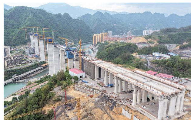
这是5月26日拍摄的西渝高铁任河特大桥建设现场(无人机照片)。5月26日,随着最后一方混凝土浇筑,由中铁十二局承建的西渝高铁任河特大桥主桥墩施工顺利完工,标志着大桥进入梁部施工阶段,为全线通车奠定了坚实基础。西渝高铁任河特大桥位于重庆市城口县境内,全长1180.52米,共有墩台19个,最大墩高132米,为西渝高铁康渝段重难点工程。西渝高铁是全国“八纵八横”高速铁路通道之包(银)海、京昆通道重要组成部分,全长739公里,设计时速350公里。【新华社记者 唐奕 摄】
