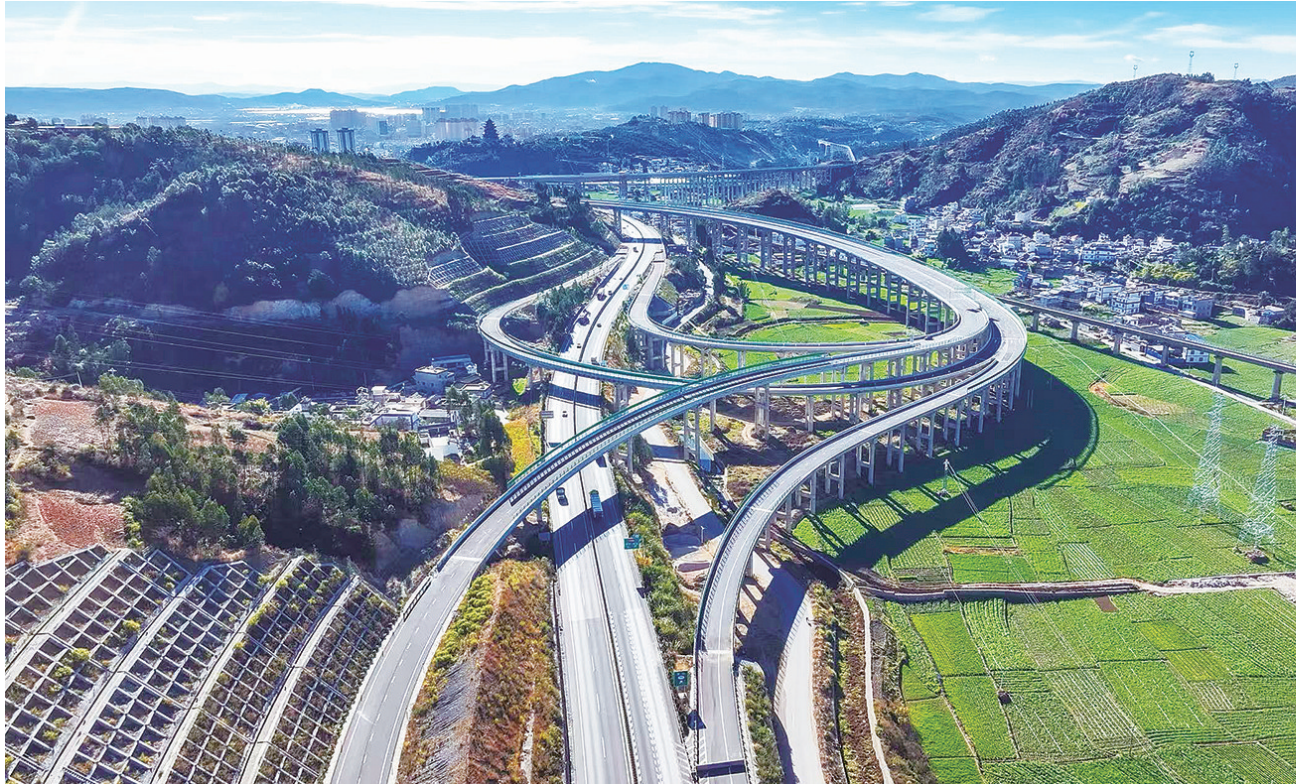
宾南高速公路及立交桥。图片由云南宾南高速公路有限公司提供。
