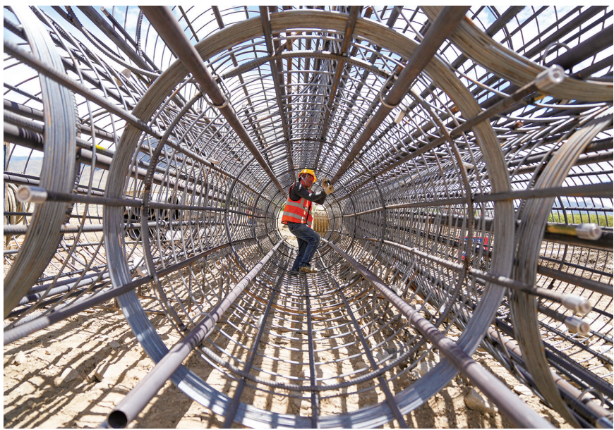
工人在萨热路跨江大桥建设现场绑扎声测管(6月18日摄)。 萨热路跨江大桥位于西藏山南市乃东区，是山南市“十四五”重大市政基础设施项目。6月18日，第一片箱梁养护强度达到设计标准，大桥建设进入架梁施工阶段。260余名施工工人日夜奋战在钢栈桥和两岸的桥梁结构建设中。 由中铁建城通公司承建的山南萨热路跨江大桥全长1457米，横跨海拔雅鲁藏布江山南段。大桥建成后，将成为连接雅江两岸的重要交通枢纽，有力推动山南市与拉萨市的一体化发展进程，进一步强化区域产业互补，方便群众出行。 【新华社记者 晋美多吉 摄】
