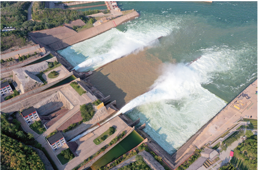
这是6月23日在河南济源拍摄的小浪底水利枢纽工程调水调沙现场（无人机照片）。当日，水利部黄河水利委员会通过联合调度万家寨、三门峡、小浪底等水库，启动实施2025年黄河调水调沙，本次调水调沙将历时17天左右。
