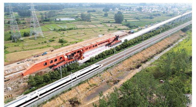
新建沪宁合高铁安徽段前四标最后一根40米箱梁完成架设(6月25日摄，无人机照片)。
