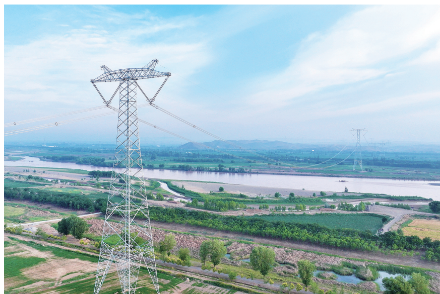
这是6月29日拍摄的“宁电入湘”工程宁夏中卫市境内跨黄河段线路(无人机照片)。6月29日,宁夏至湖南±800千伏特高压直流输电工程完成168小时试运行,具备400万千瓦送电能力,正式开始向湖南送电。“宁电入湘”工程于2023年5月获得核准,是我国首条获批的以输送“沙戈荒”风电光伏大基地新能源为主的特高压输电通道。工程起于宁夏中卫市中宁换流站,途经甘肃、陕西、重庆、湖北,止于湖南省衡阳市衡阳换流站,线路全长约1616公里。预计今年9月中旬,“宁电入湘”工程将整体竣工投产,届时将具备800万千瓦送电能力。【新华社发(袁宏彦 摄)】
