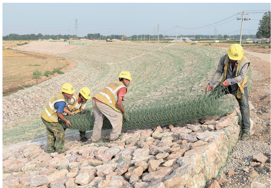
6月29日,中铁十八局集团的工人在兰沟洼蓄滞洪区(高碑店段)新古城镇安全区围堤建设工地施工。近日,由中铁十八局集团承建的河北省重点水利项目兰沟洼蓄滞洪区(高碑店段)核心控制性工程进展顺利,“东务分洪闸”与“东马营退洪闸”两座大型闸门已完成安装调试。据介绍,兰沟洼蓄滞洪区项目地处保定市管辖的高碑店市、涿州市和定兴县境内,是承泄南拒马河、白沟河超标准洪水的洼淀,建成后可大幅提升区域防洪标准,对保护沿线农田和铁路等交通基础设施具有重要意义。【新华社记者 杨世尧 摄】
