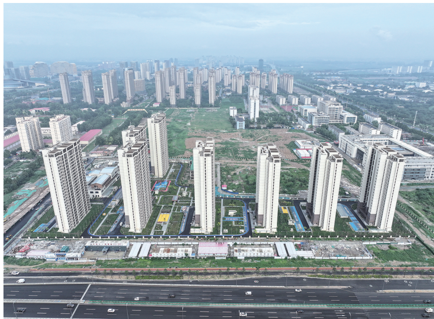
这是7月3日拍摄的保定市城中村改造小营坊安置区项目(无人机照片)。
