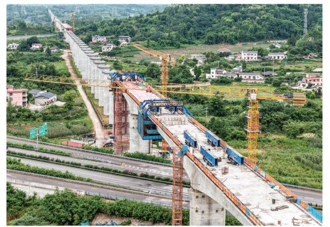
这是7月8日拍摄的成渝中线高铁上桥枢纽互通双线特大桥建设现场(无人机照片)。当日，由中铁五局承建的成渝中线高铁上桥枢纽互通双线特大桥连续梁顺利合龙。该连续梁全长约242米，是成渝中线高铁重庆段跨度最大的连续梁。上桥枢纽互通双线特大桥位于重庆市铜梁区，全长3271.6米，上跨重庆三环高速及铜安高速公路，共设有92个桥墩，2个桥台。成渝中线高铁是我国“八纵八横”高铁网沿江通道的重要组成部分，正线全长292公里，设计时速350公里。
