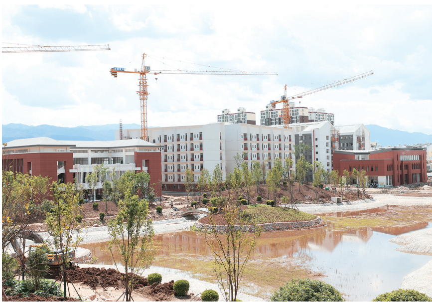
正在建设中的弥渡一中新校区。(摄于7月1日)
