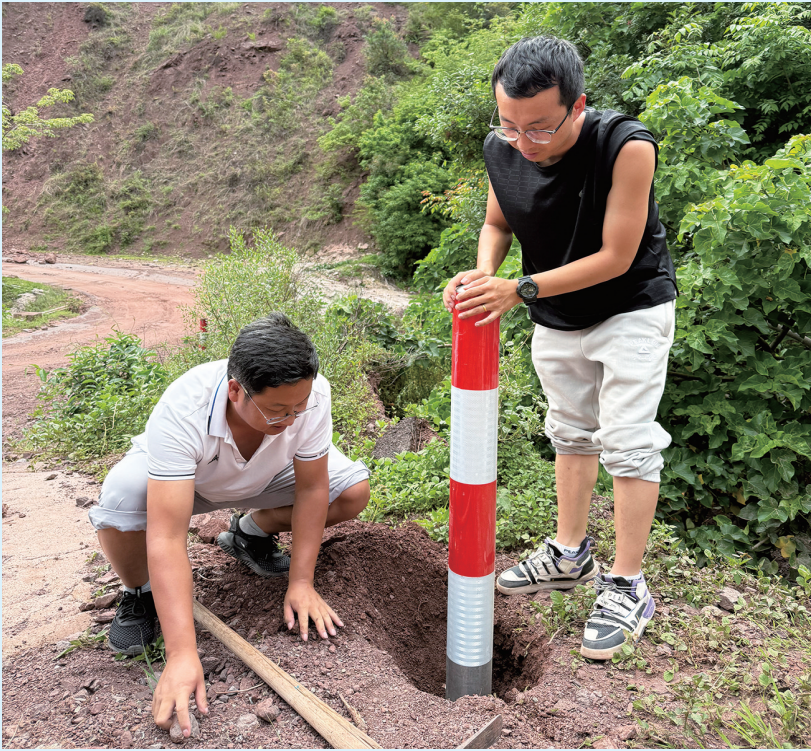
6月30日，漾濞县鸡街乡公路危险路段排查党员突击队队员在隐患路段醒目位置安装警示标志。 为有效应对强降雨后道路安全隐患，鸡街乡党委、政府迅速行动，成立公路危险路段排查党员突击队，对辖区内道路展开拉网式勘察。突击队员深入一线，重点排查雨后易发滑坡、塌方等风险点，并提醒过往车辆行人注意安全。本次共排查辖区内公路约十公里，安装警示标志10处。 [赵蛟龙 摄]
