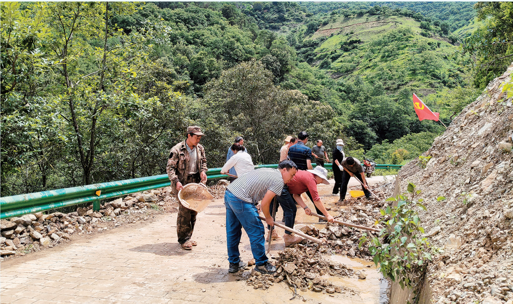
漾濞县漾江镇紫阳村党员志愿先锋队在清理路面落石。(摄于7月3日) 近期,因降雨频繁,紫阳村多处村组道路出现落石、受损等情况,村党总支不等不靠,积极组织党员、群众自带工具,以分段、分组的方式投身到道路清理和修复工作中,力争将水毁损失降到最低,确保群众出行顺畅与安全。 [通讯员 李惠赞 罗云婷 摄影报道]
