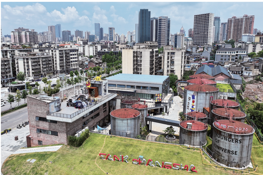
7月13日拍摄的长沙油脂厂(无人机照片)。 在湖南省长沙市天心区,12座外表斑驳的油罐排列在湘江畔。这里曾是长沙市粮油公司油脂仓库,见证了市民提着油壶凭票打油的历史,上世纪90年代停止运营后一度闲置。 今年7月初,改造后的长沙油脂厂焕新开市。该项目引入了策展商业、文化创意、体验餐饮等新业态,咖啡店、展览馆、艺术商店等集聚于此,满满的工业风和新潮多元的消费场景吸引市民和游客。
