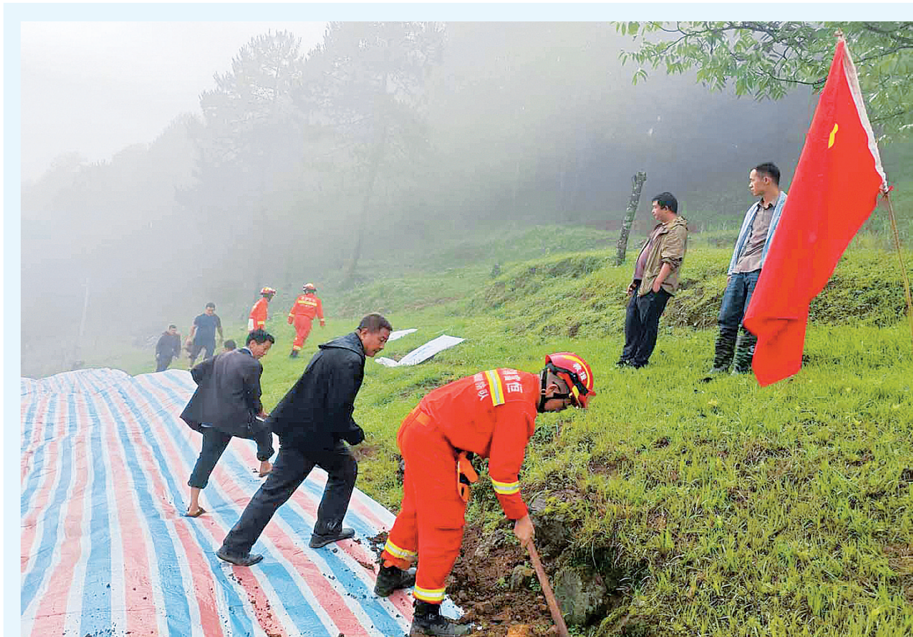
漾濞县富恒乡干部群众合力铺设防水布,并采用“人工+机械”方式疏通道路。(摄于7月8日) 面对强降雨地质灾害隐患,富恒乡科学部署,迅速行动,依托“1262”预警叫应机制,构建乡、村、组三级应急网络,组织转移受威胁群众,专人监测危险区域,设置警戒标识,筑牢防汛安全屏障。 [通讯员 冯杨雨 宇春丽 摄影报道]
