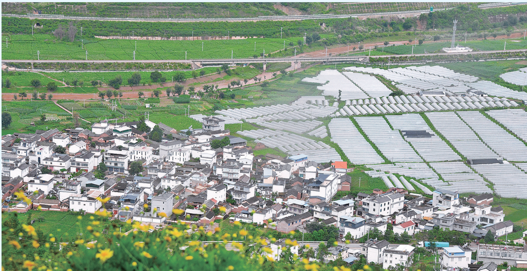
巍山县巍宝山乡建设村委会甸尾厂村,错落的民居与河流、田园、公路共同构成了一幅美好的画卷。(摄于7月21日)
