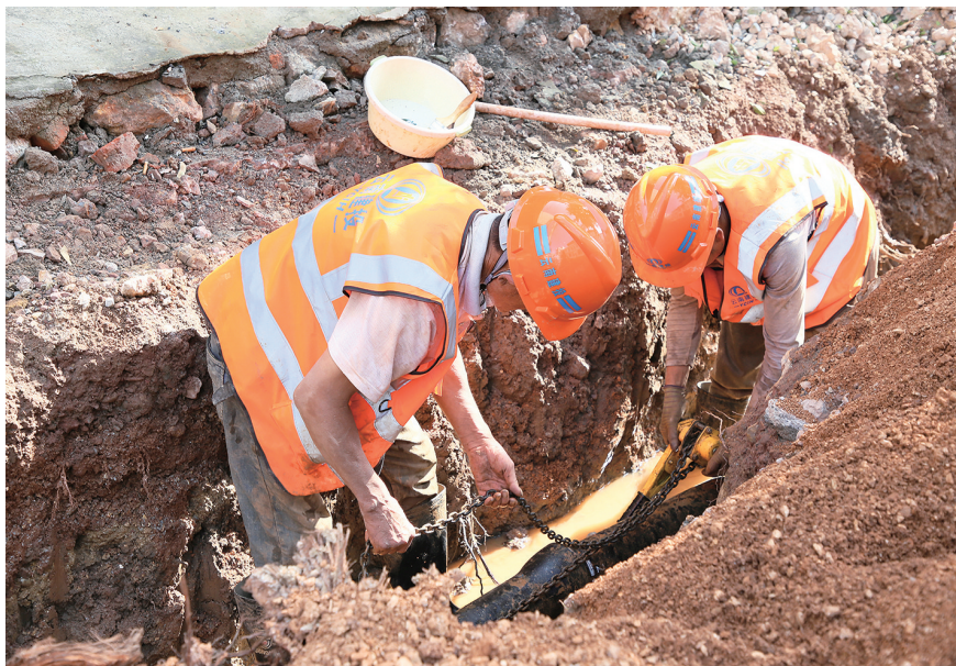
工人正在红岩镇北大街改造现场进行施工。(摄于7月9日)
