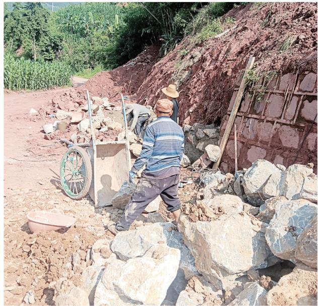
漾濞县瓦厂乡蛇马村群众正在修建挡墙。(摄于7月21日) 日前，受强降雨影响，蛇马村部分通村组道路受损。群众积极投工投劳，对道路进行抢修。
