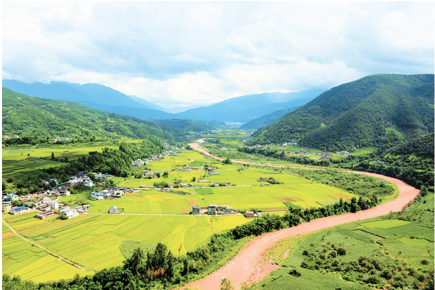
“十四五”期间,大漾云高速公路建成通车,漾濞群众出行更加便利。 左图:在漾濞县苍山西镇淮安村栗树坡远眺,青山环抱间,田野与村落勾勒出田园画卷。(摄于2019年9月14日) 右图:同一视角下,大漾云高速公路穿河谷而过,蜿蜒向前,桥梁与隧道点缀在绿水青山间。(摄于2024年10月2日)
