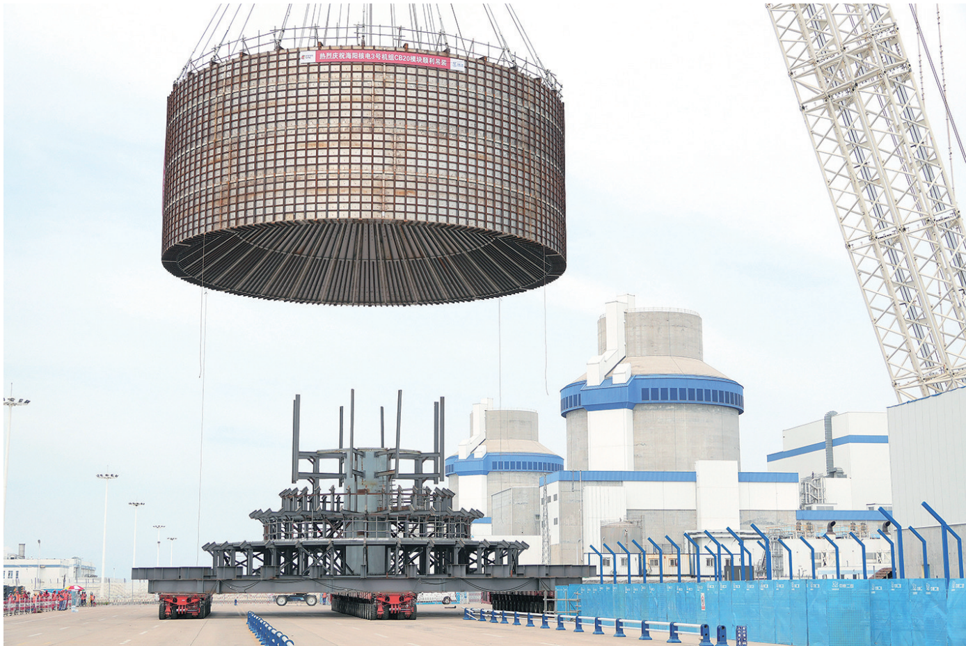
这是8月4日拍摄的山东海阳核电3号机组核岛CB20模块吊装现场。
