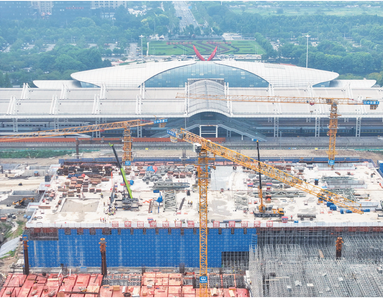
这是8月6日拍摄的新建上海至南京至合肥高铁南通站站房钢结构首节桁架吊装现场(无人机照片)。 当日,由中铁建工承建的新建上海至南京至合肥高速铁路南通站站房钢结构首节桁架吊装完成,标志着项目正式进入钢结构安装新阶段。 据介绍,新建南通站站房及相关工程是沪渝蓉高铁的重要组成部分,站房建筑面积约55000平方米,建成后站场总规模达3场9台20线,对助力区域内交通融合发展、推动长三角更高质量一体化发展等有重要意义。 【新华社记者 季春鹏 摄】
