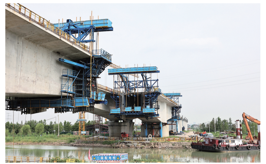
8月12日,工人在沪宁合高铁上海特大桥跨罗蕴河连续梁浇筑作业面施工。当日,由中铁四局承建的沪宁合高铁上海特大桥跨罗蕴河连续梁施工启动,沪宁合高铁建设稳步推进。沪宁合高铁是沪渝蓉高铁的东段线路,起自上海市新建上海宝山区,接入既有合肥南站,线路全长约554公里,设计时速350公里,承担沿江通道主要路网客流、沿海及京沪通道部分直通上海客流的运输任务。该项目建成后,将形成一条连接上海、南京和合肥都市圈的快速新通道。
