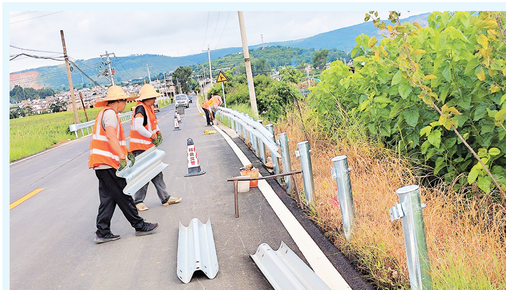
护路工人们正在祥云县云南驿镇的084乡道上安装安全护栏。(摄于8月8日)
