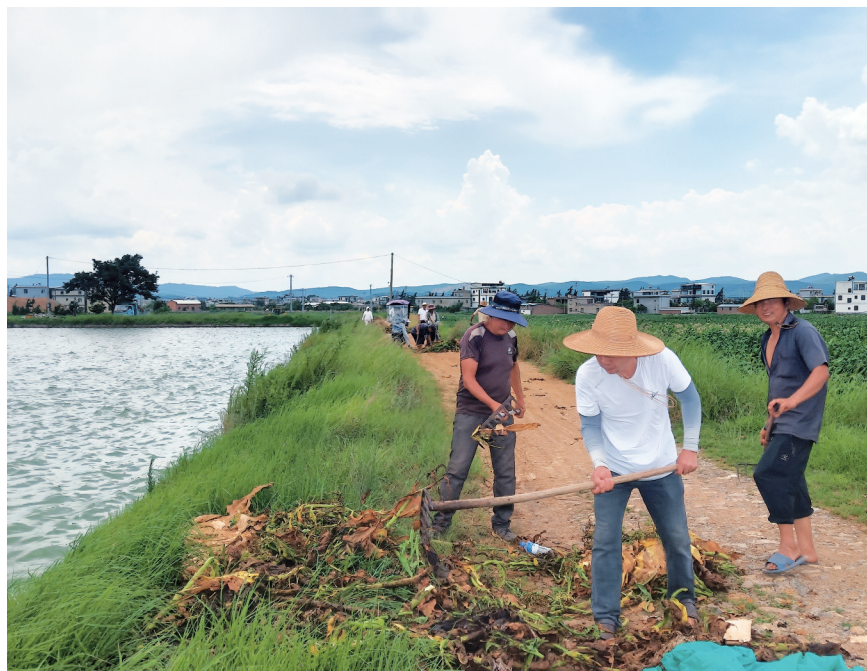
祥云县刘厂镇王家庄村组织党员志愿者队伍，对辖区内重要河段、排水涵洞、沟渠及临坡路段等开展清淤疏浚工作，筑牢防汛“安全堤”。（摄于8月14日）
