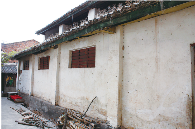
曲硐老洗澡池外部。
