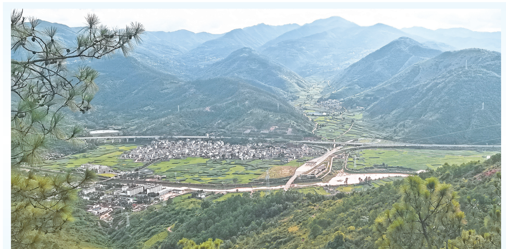
巍山县巍宝山乡建设村大南高速公路巍山南出入口，道路、村庄、河流、远山交相辉映。(摄于8月16日) 近年来，巍山县加大道路交通设施建设，构建高速铁路、高速公路、农村公路等交通路网体系，为群众提供更加便捷的出行条件。
