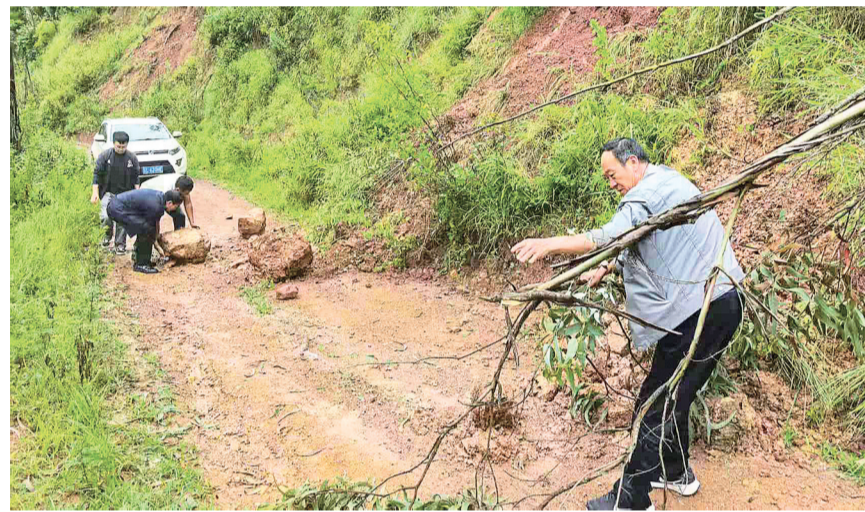
永平县北斗乡党员干部和群众正在对村组道路进行清理保通。(摄于8月15日) 强降雨过后,北斗乡闻令而动,迅速组织党员干部、辖区群众2500余人次,开展清淤疏堵、道路清理及安全隐患排查行动,全力保障群众正常的生产生活。 [通讯员 马海云 马婉娟 摄影报道]
