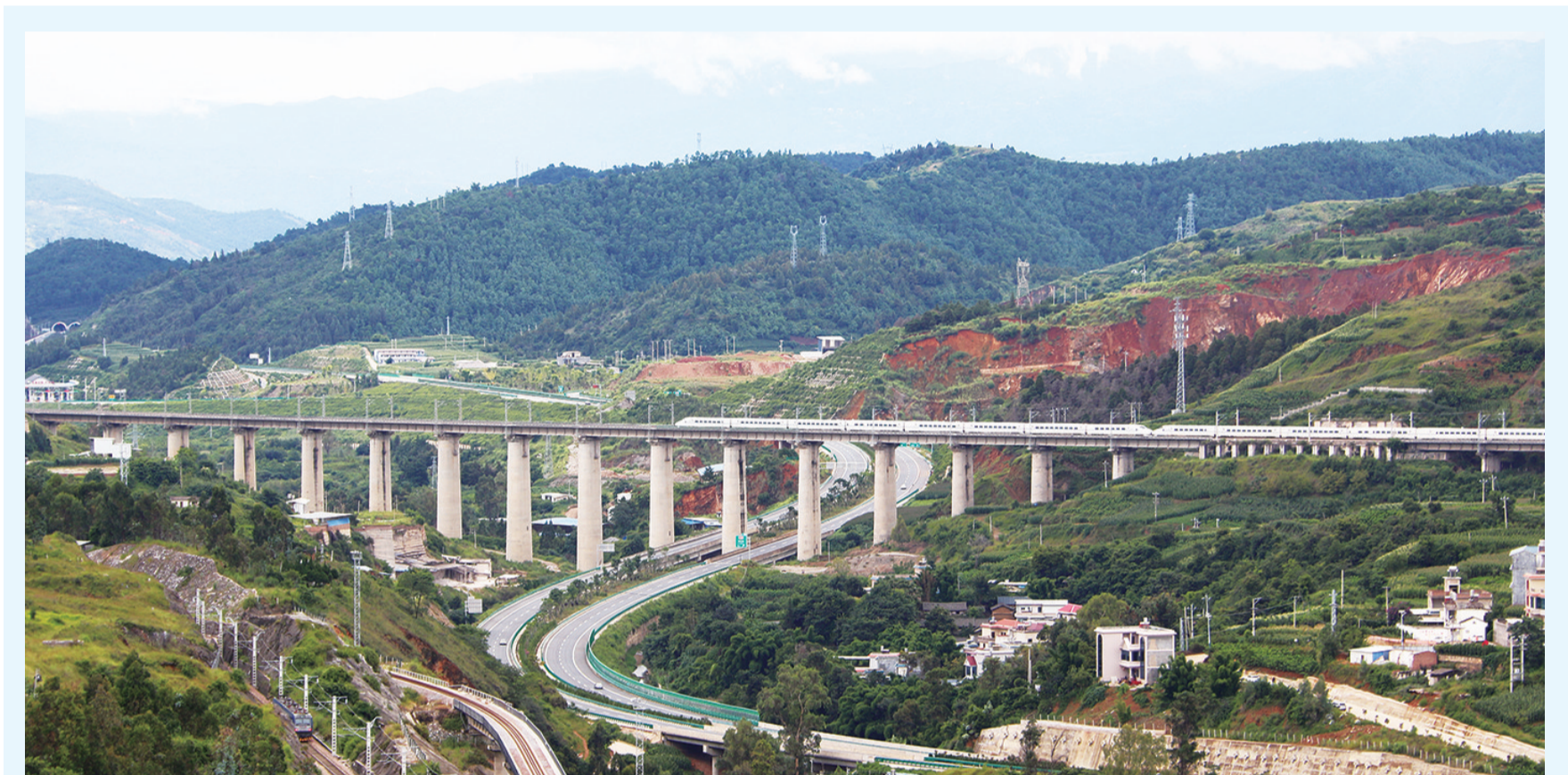
一列动车驶过祥云县平坝高架桥。(8月23日无人机航拍图片)
