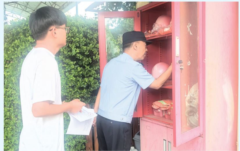
民警对学校消防设施进行检查。(摄于8月27日)
